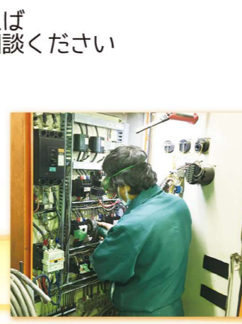
工場内配線工事
