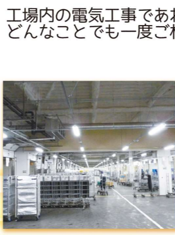
工場内照明工事
